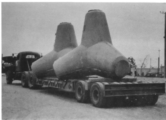
Fig. 8. Transporte de tetrapodos desde la planta a la obra. (Arica).
