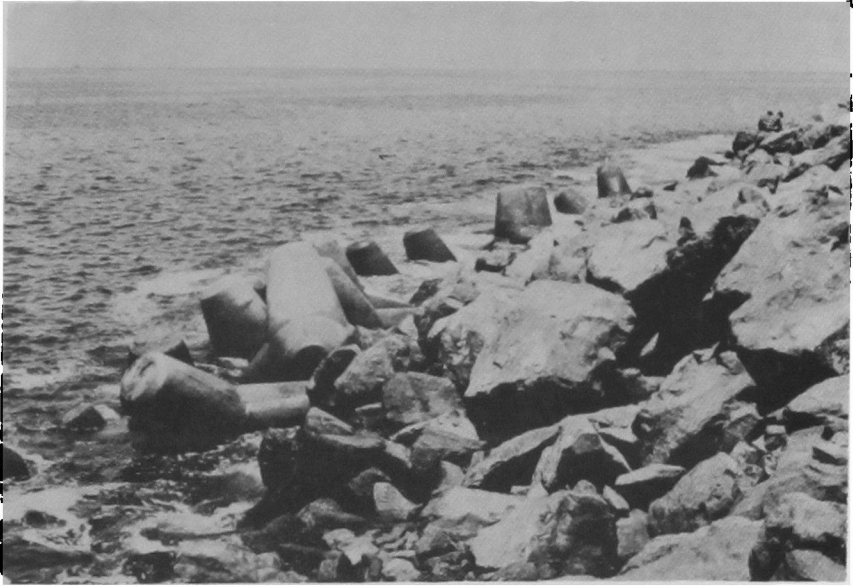
Fig. 10. Primeros tetrápodos colocados en obra. (Arica).
